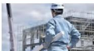
建設・工事現場
